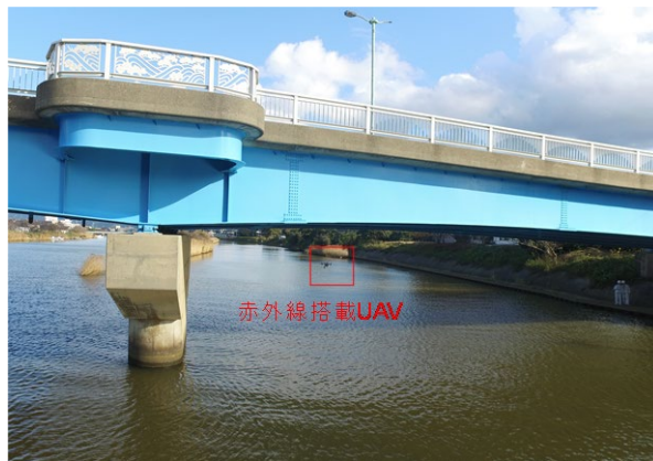
図-4 距離測定 UAV で撮影した赤外線画像の撮影様子
