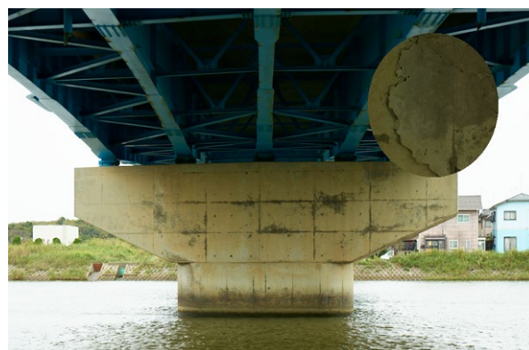
図-2 超高解像度カメラを用いた点検対象箇所の画像
