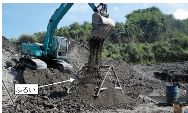
図-3 土石流堆積物のふるい分け
