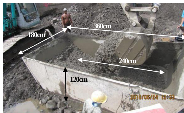
図-4 鋼製ボックスを使用しての練混ぜ
