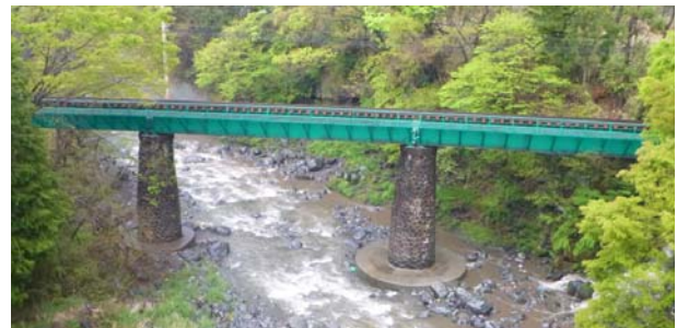
写真-4 河川橋梁での補強例
