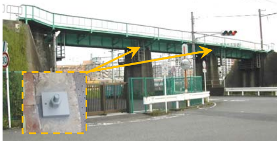
写真-3 陸上橋梁での補強例
