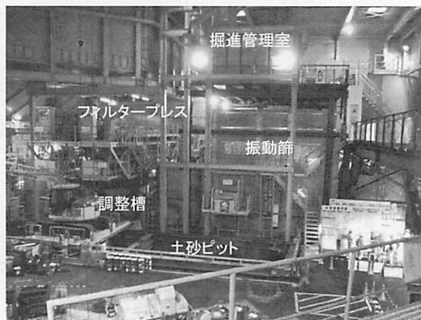
写真-2 立体化立坑（処理プラント）
