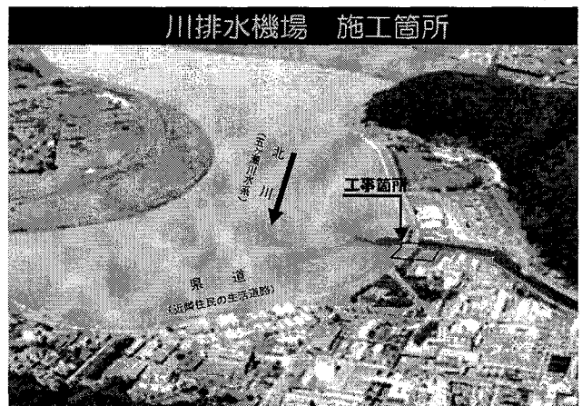
図－4 A川排水機場施工箇所 3)
