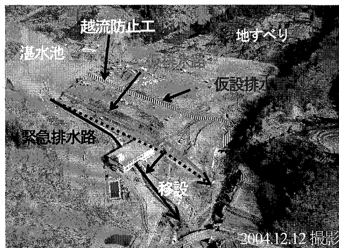
写真—2 東竹沢地区河道閉塞での緊急対策状況
