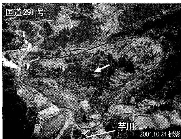
写真—1 東竹沢地区河道閉塞の状況
