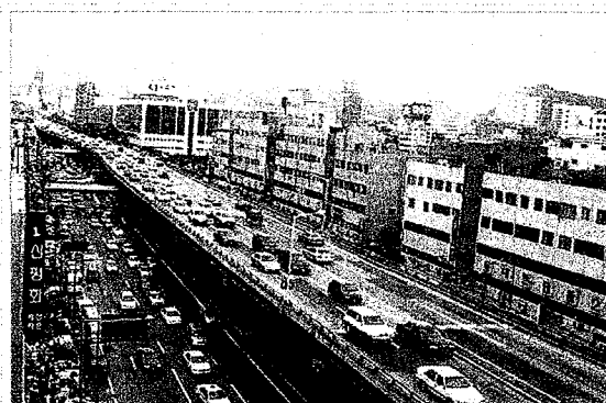
写真-1 清溪川復元「前」状況
