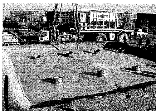
写真-2 試験施工状況
