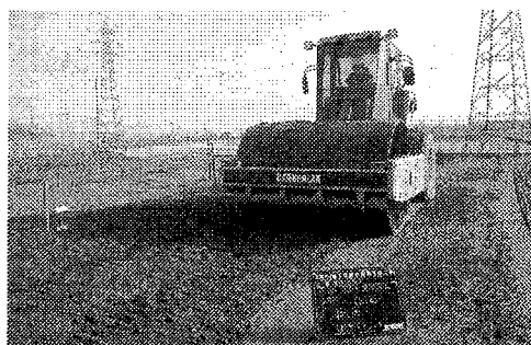
写真-5 初回転圧状況
