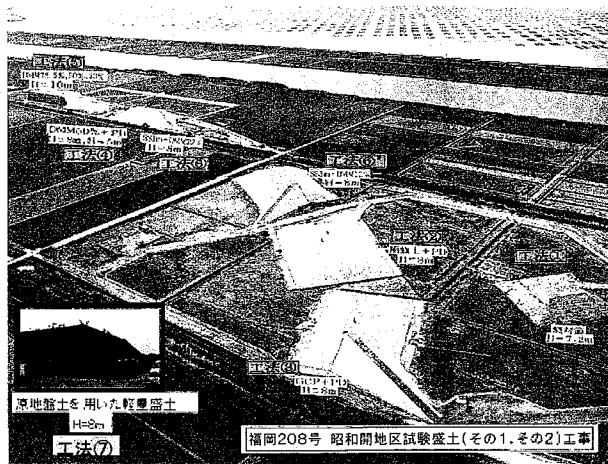
写真-1 試験盛土全景
