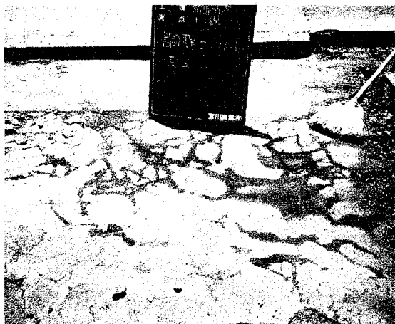
写真-4 RC床版上面状況
