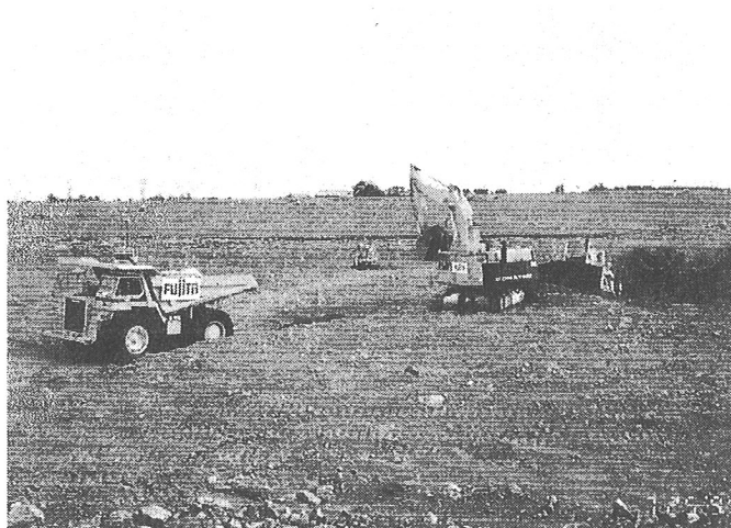
写真-4 施工状況(2期工事)
