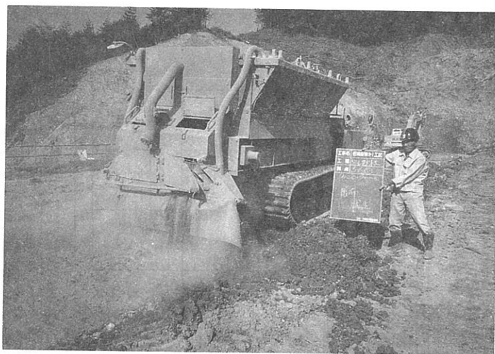
写真-1 セメント撒布車 撒布状況
