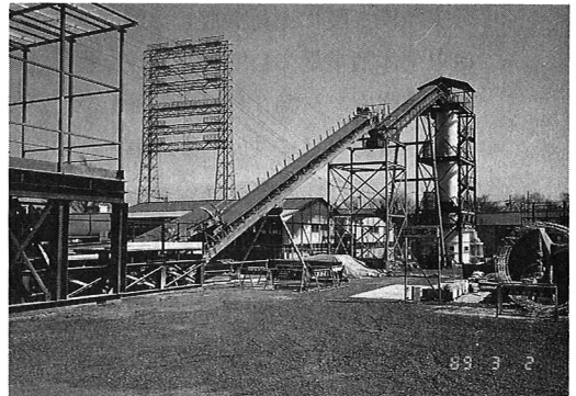
写真－1 縦型水槽および打設設備
