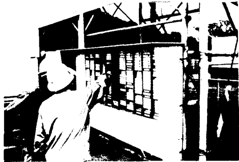
写真-2 現場における出面板使用状況
