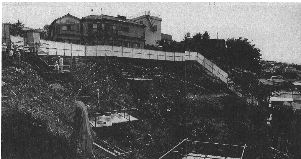
写真1 土留工施工前
