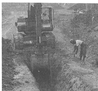
b') 掘削、整正
