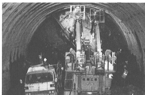
写真-1 装薬孔とロックボルト孔の並行作業
