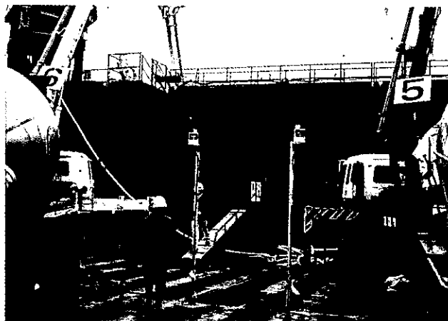
図-5 赤外線センサーの配置
