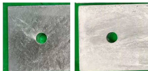
図-9 連結板の接触面
