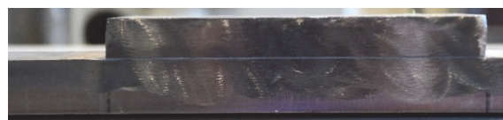
図-5 当て板と母材の側面の仕上げ
