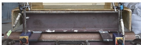
図-7 逆C形とした場合の床版のH形鋼によるかさ上げ状況
