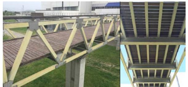
b) 木床版 (取替前) c) GFRP 縦桁(取替前)
