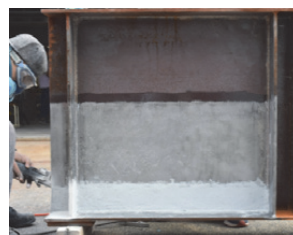
(a) 欠損部への不陸修正材の充填
