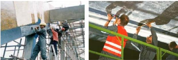
図-13 CFRPによる橋梁の補強例<sup>2)</sup>
