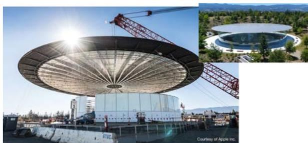
図-4 CFRP製の一体屋根（Apple Campus 2）<sup>2)</sup>
