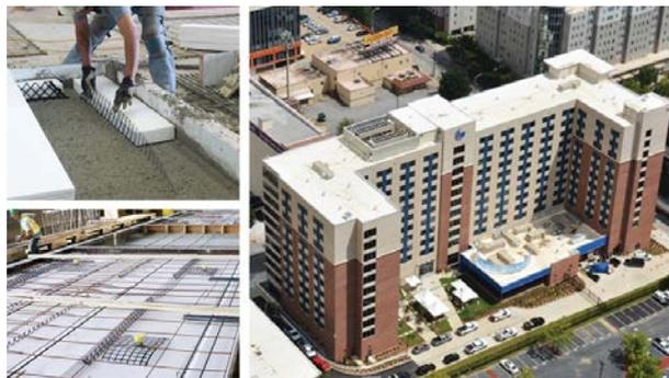
図-10 コンクリート/ESP/CFRPハイブリッドのプレキャスト適用例（GSU Piedmont Central student housing, Atlanta）<sup>4)</sup>
