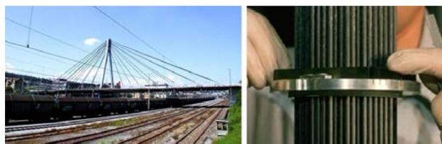
図-11 CFRP-UD ロッドによるパラレルケーブル（右）と斜張橋の適用事例<sup>5)</sup>
