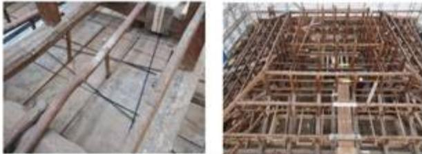
図-20 CFRP ワイヤー (カボコーマストランドロッド) による善光寺経蔵の耐震補強
