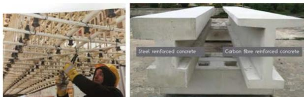
図-8 FRP製補強筋<sup>2)</sup>
