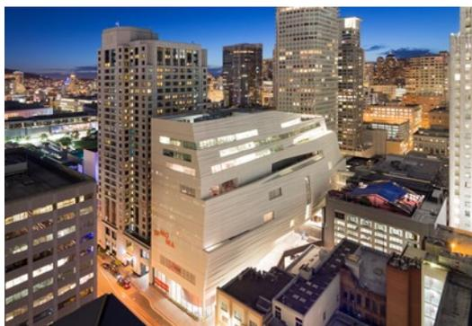
図-3 FRP パネルを外壁材に採用したサンフランシスコ近代美術館<sup>2)</sup>
