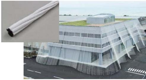
図-19 CFRP ワイヤー (カボコーマストランドロッド) による耐震補強 (小松精練 fa-bo)
