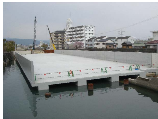
図-26 完成時の状況(満潮時)
