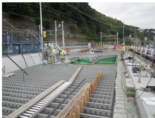
図-30 施工状況（FRPパネルの人力施工）
