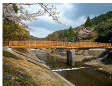
図-12 岩屋公園平安橋の供用状況
