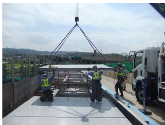
図-32 新木津川橋でのFRPパネル設置状況
