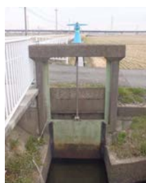
図-36 35年以上経過したローラーゲートの状況
