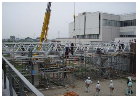
図-3 ものづくり大学第2連絡橋の架設状況
