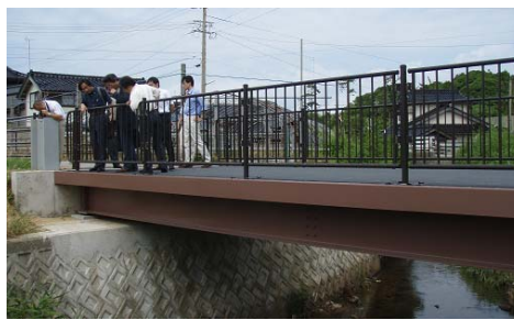
図-6 羽咋巖門自転車道13号橋の供用状況
