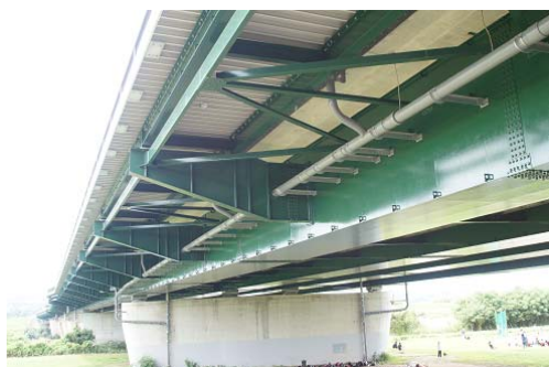
図-33 完成時のFRP歩道床版の下面状況
