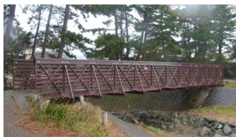
図-8 はまなす橋の供用状況
