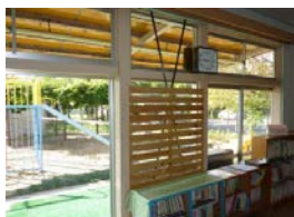
写-11 内部補強ブレース
