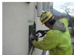
写-5 ブレース取付
