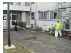
写-7 ブレース材運搬
