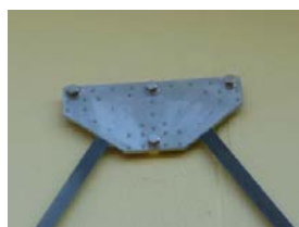
写-13外部ブレース接合部1
