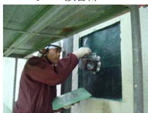
写-4 接合部炭素繊維シート取付
