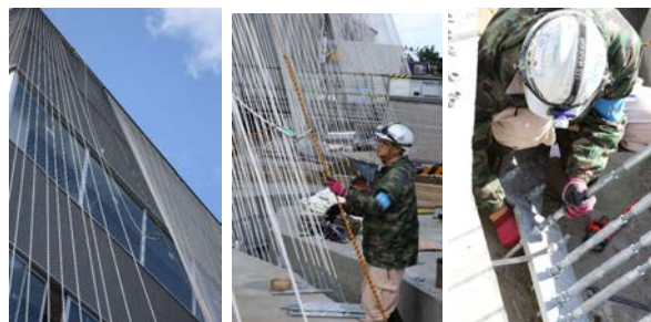
写-17 外部ブレース施工
