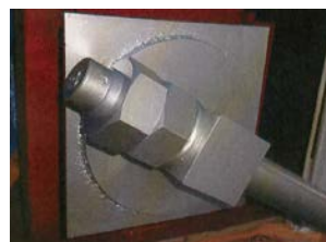
写-8 接合部取付
