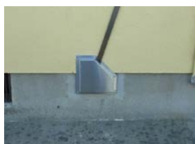
写-14外部ブレース接合部2
