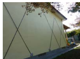
写-12 外部補強ブレース
