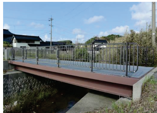
図-1 GFRP 製歩道橋 (羽咋自転車道)
