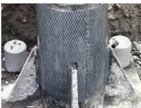
図-11 シート貼付工
