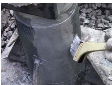
図-15 仕上塗装工
