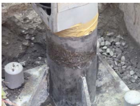
図-7 施工対象の照明柱（掘削後）
