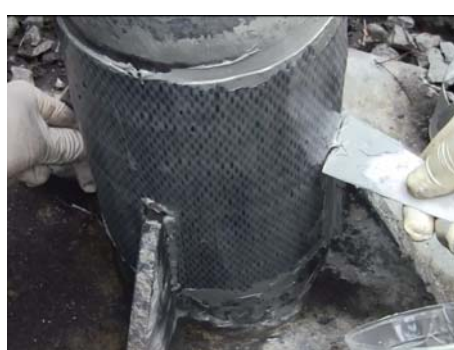
図-12 シート端部処理工
