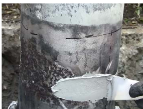
図-9 パテによる不陸修正工
