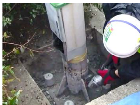
図-8 下地処理工
