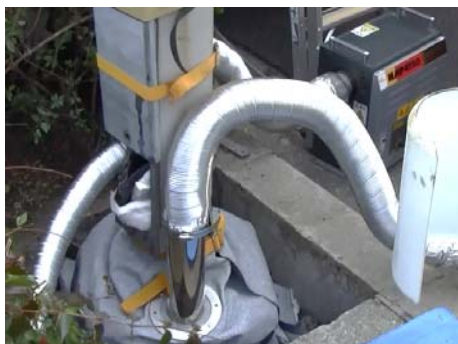
図-13 加熱硬化工
