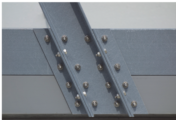
図-9 6m検査路における下弦材格点部のボルト接合
