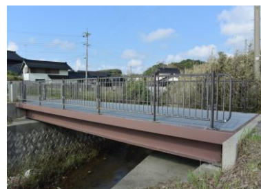
図-1 FRPを用いた土木構造物（羽咋巖門自転車道）
