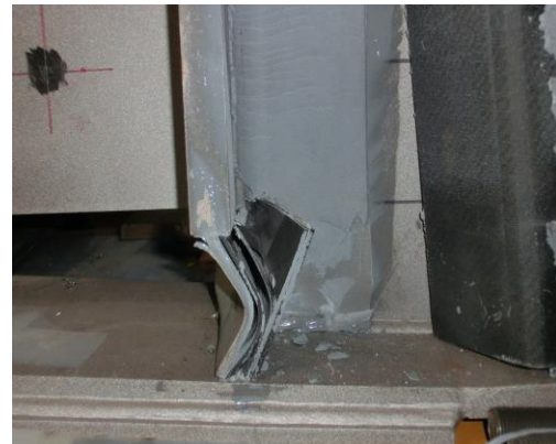
写真6 Case-3 の CFRP 成形部材の剥離
