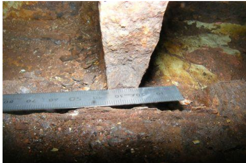
(a) 26mm厚の支点上補剛材が16mmまで減肉
