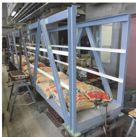
図-17 製作された実大模型への砂のうの設置状況
