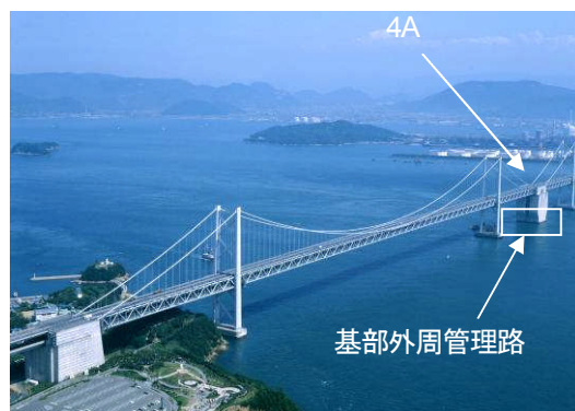
写真-9 試験施工体設置位置（南北備讃瀬戸大橋）
