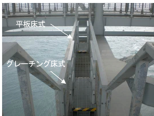
写真-7 大鳴門橋管理路上の試験施工体（2009年撮影）
