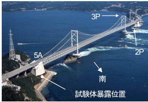
写真-2 暴露試験体設置場所（大鳴門橋）
