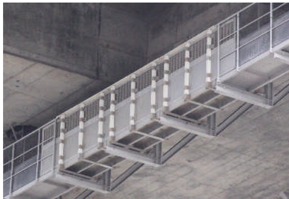
写真-13 櫃石島高架橋13P北面の試験施工体
