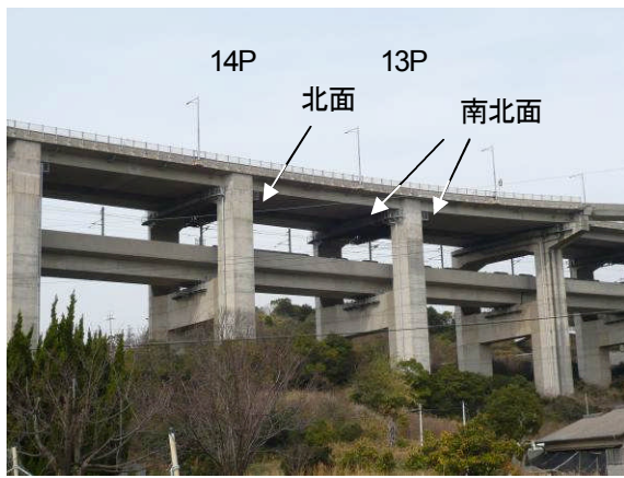
写真-12 試験施工体設置位置（櫃石島高架橋）
