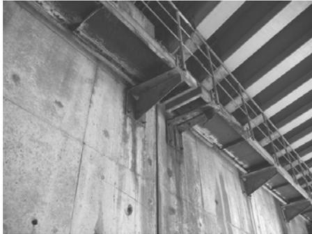
図-19 鋼製検査路の腐食状況
