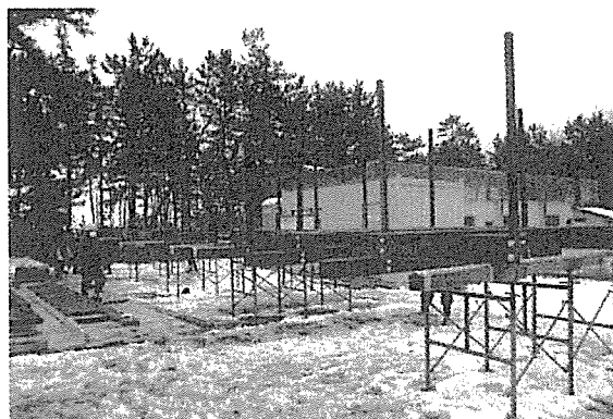
写真-1 鉛直ポスト、横桁取り付け状況
