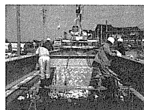
写真-4 横桁架設
