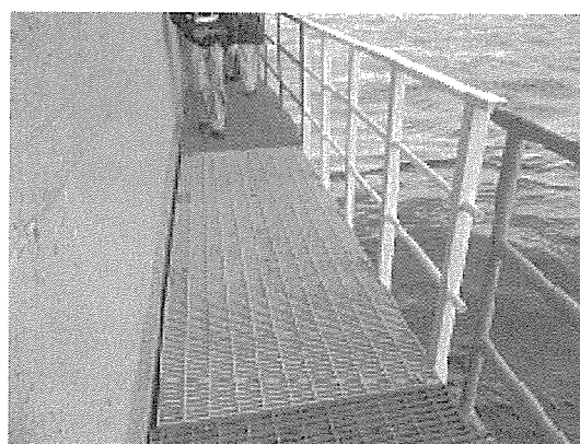
写真-6 試験施工 (南北備讃瀬戸大橋)
