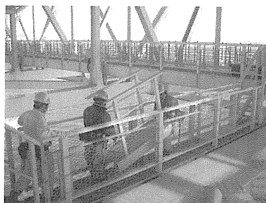
写真-5 GFRP製管理路の運搬 (大鳴門橋)
