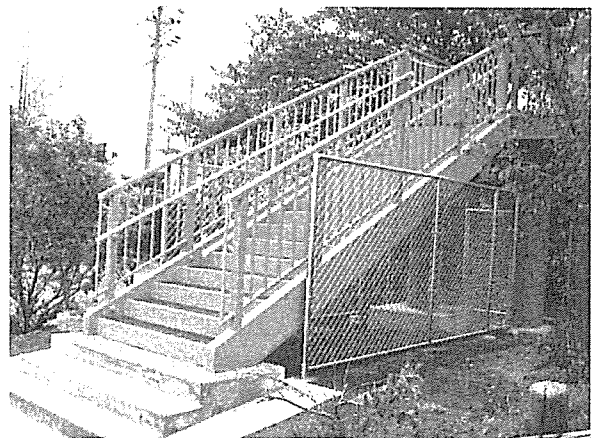
図-1 FRP 製階段の概観
