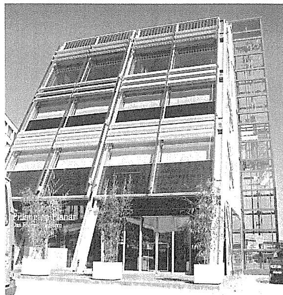
写真－2 アイキャッチャーの外観
