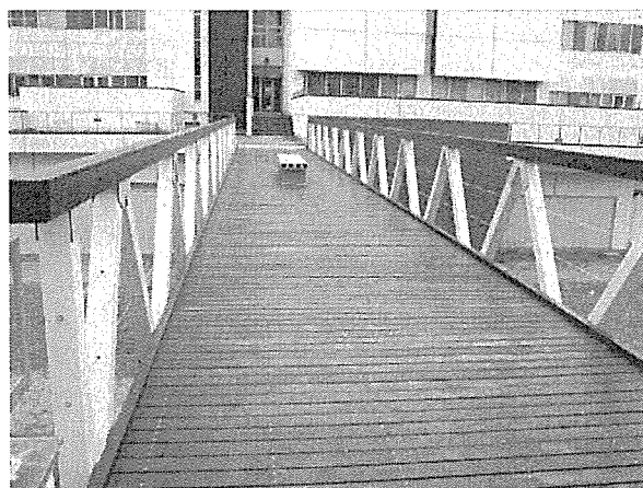
図-5 完成後のFRPトラス橋（歩道面）
