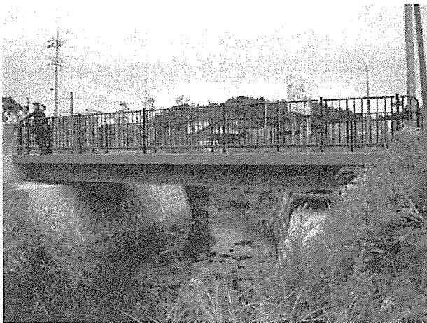
図-10 完成後の羽咋自転車道 13 号橋
