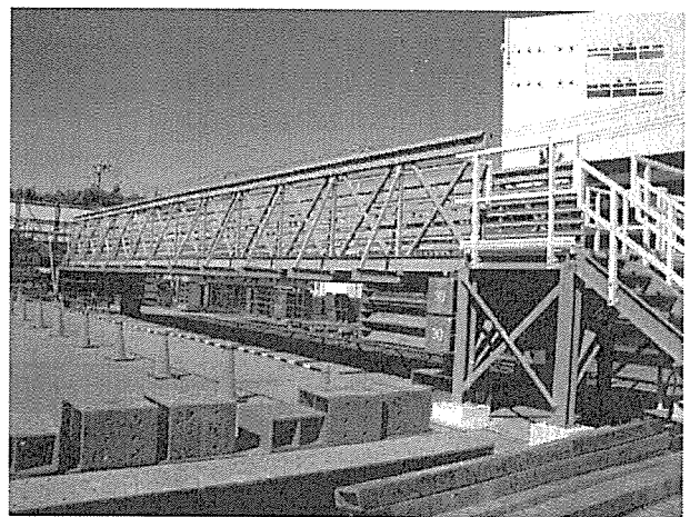
図-15 試験橋の全体外観
