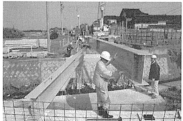
図-8 主桁設置状況
