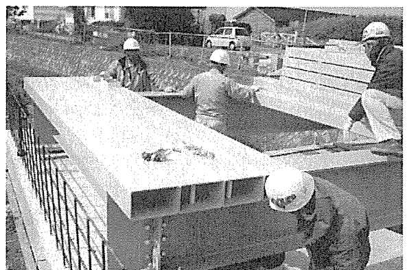
図-9 床版設置状況
