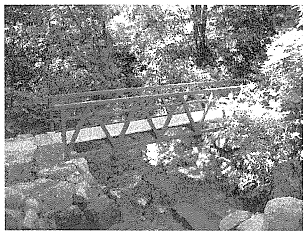
図-12 宇津江四十八滝公園 FRP 橋
