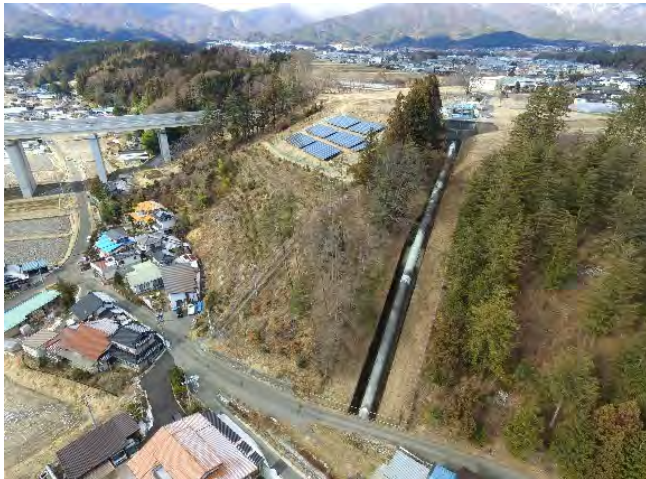
写真-2 既設水圧鉄管(工事着手前)
