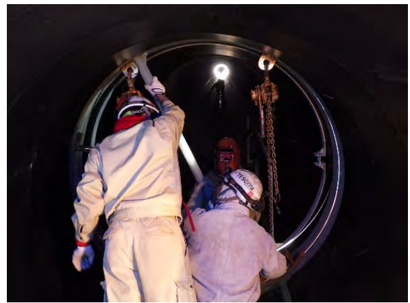
写真-17 キャスター撤去・位置調整状況
