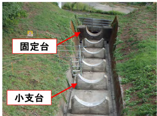
写真-7 既設鉄管撤去状況
