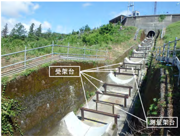
写真-10 測量架台および受架台設置状況
