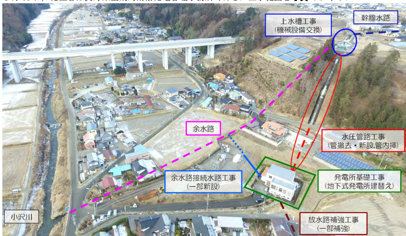
写真-1 工事範囲(工事着手前)
