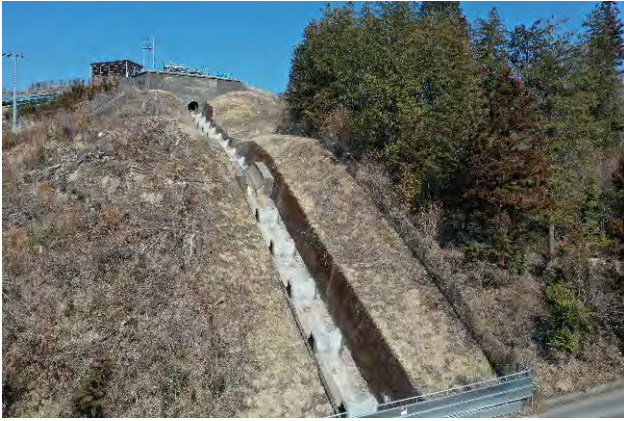
写真-8 既設鉄管撤去完了全景(露出部)
