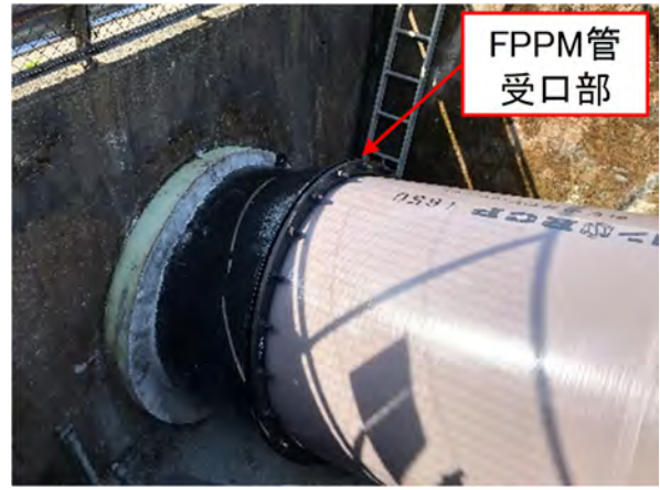
写真-23 鋼製片落ち管 接続完了
