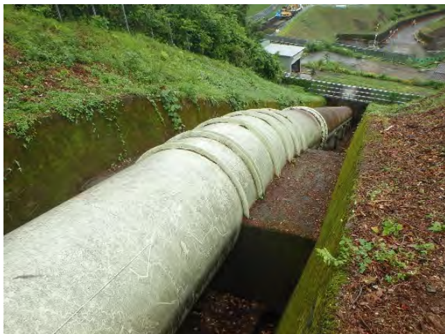
写真-4 固定台(工事着手前)
