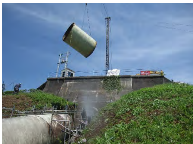
写真-6 索道による切断鉄管の運搬状況
