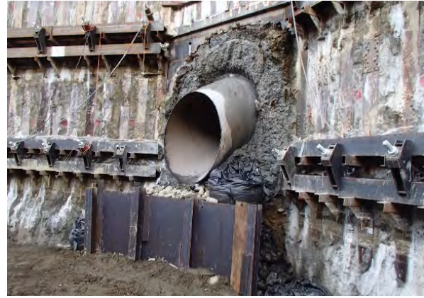
写真-9 既設鉄管撤去完了全景(土留め掘削部)
