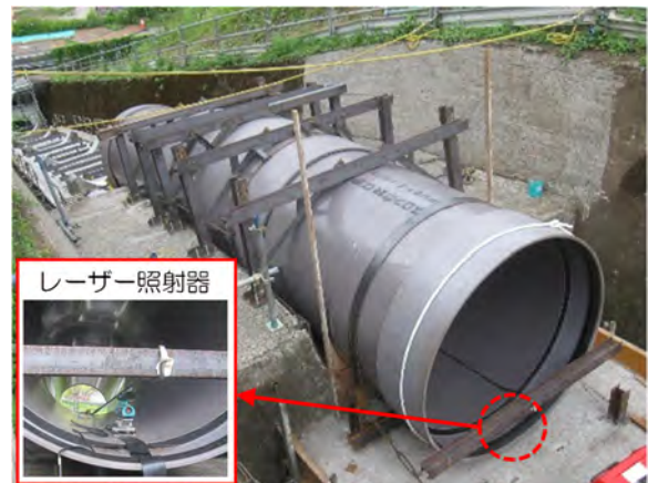
写真-11 曲管部設置状況
