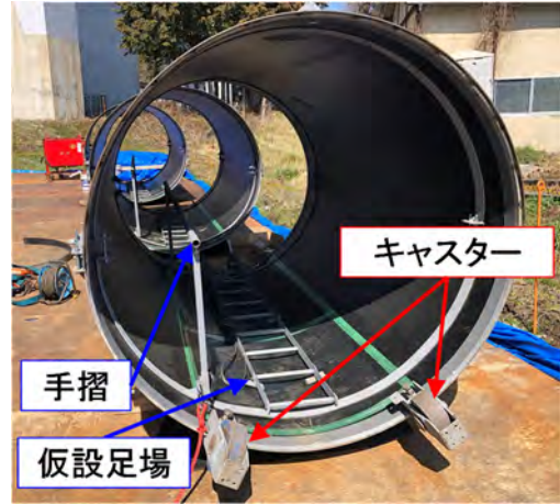
写真-15 仮設足場・キャスター装着状況
