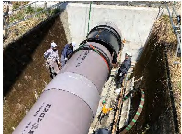
写真-24 鋼製継輪 施工状況
