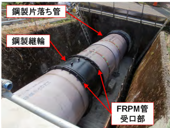
写真-25 接続完了全景
