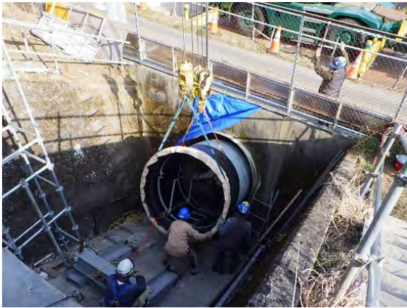
写真-22 鋼製片落ち管 施工状況
