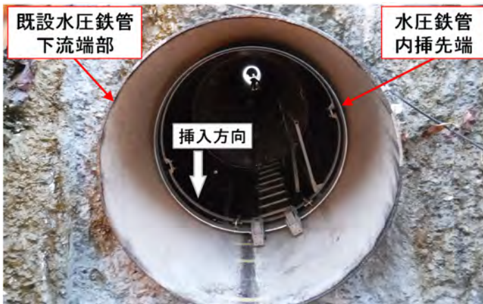
写真-16 内挿状況(最下流から上流を望む)
