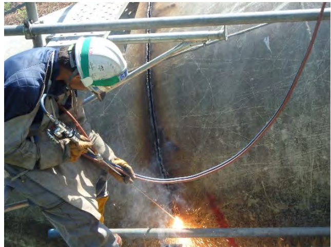
写真-5 鉄管切断状況(ランス切断)
