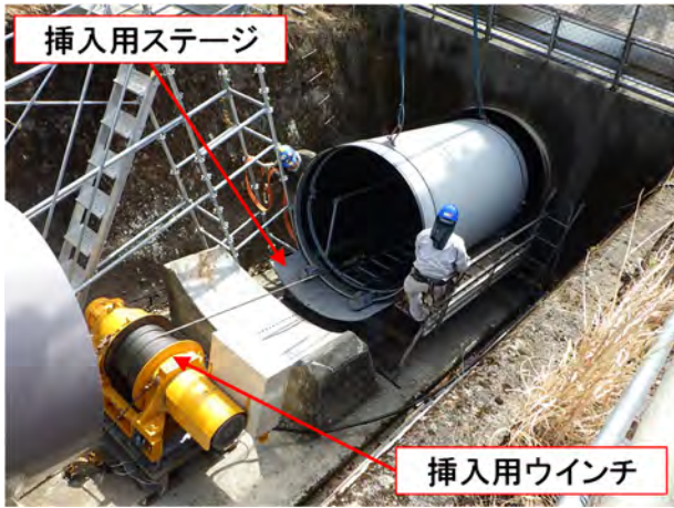
写真-14 水圧鉄管セット状況
