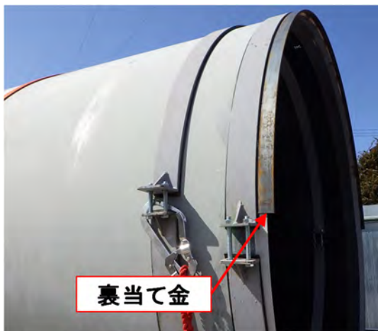
写真-13 裏当て金設置状況
