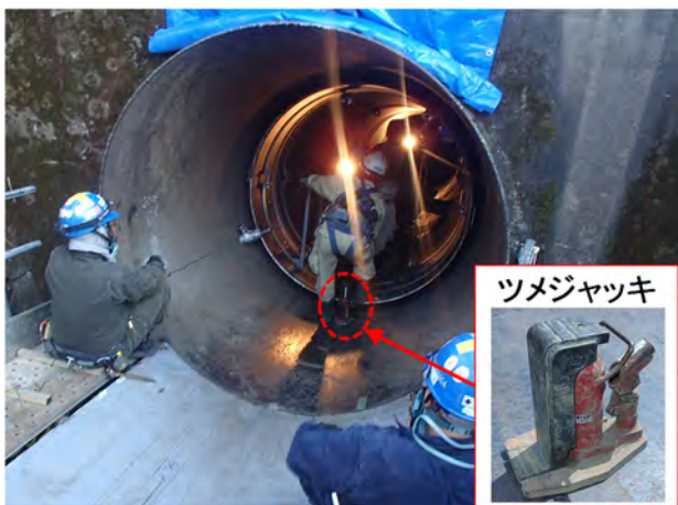
写真-18 水圧鉄管挿入完了
