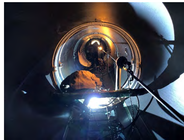
写真-21 内面溶接状況
