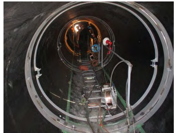
写真-19 水圧鉄管内部状況
