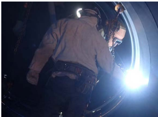
写真-20 仮溶接固定状況
