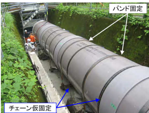
写真-12 FRPM 管の固定状況
