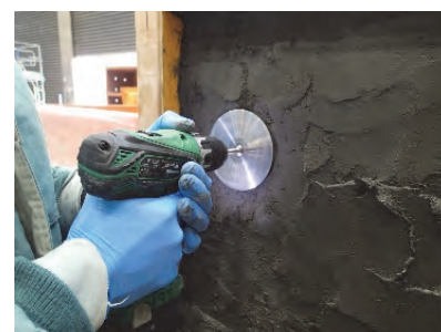
写真-2 締め固め状況
