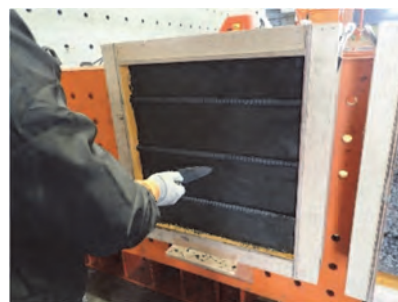
写真-1 こて塗り状況
