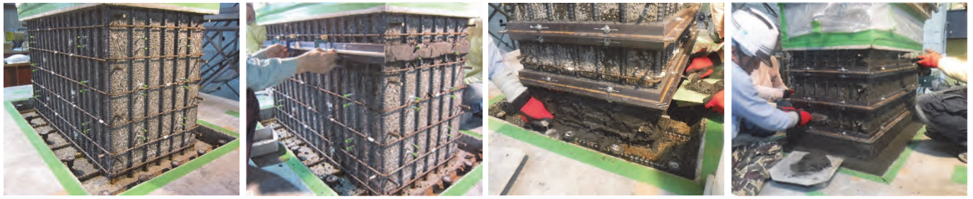
(a) 躯体表面の目粗し (b) 目地の設置 (c) ベース部の補強 (d) 柱部の補強
