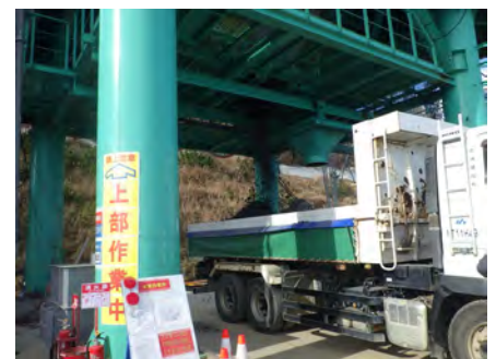
写真-2 材料製造状況
