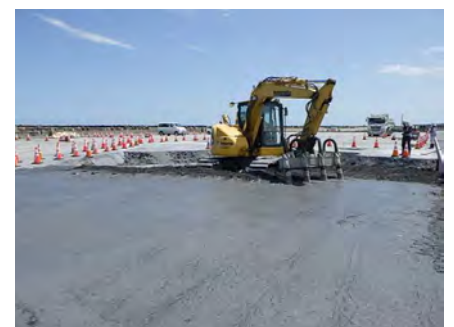
写真-3 施工状況
