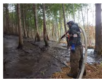
写真-6 吹付け状況
