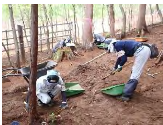
写真-5 強残渣の除去 施工状況 (左：人力での除去，右：根圏周辺の除去)
