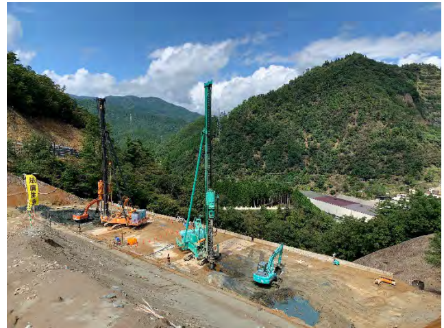
写真-2 下段部地盤改良状況
