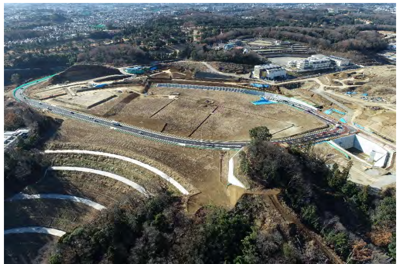
図 15 完成後の根方谷戸高盛土
