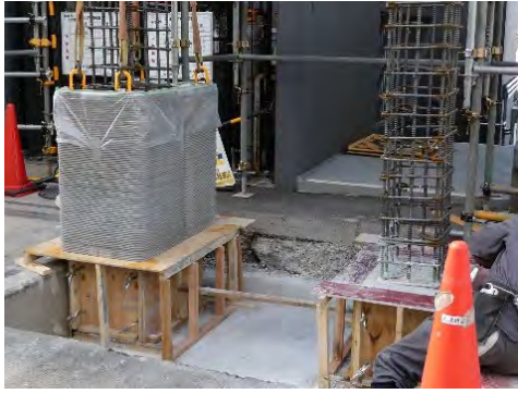
(a) 1ブロック目の設置
