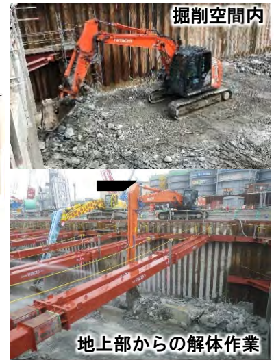
写真-5 施工実績② 既設躯体解体施工状況
