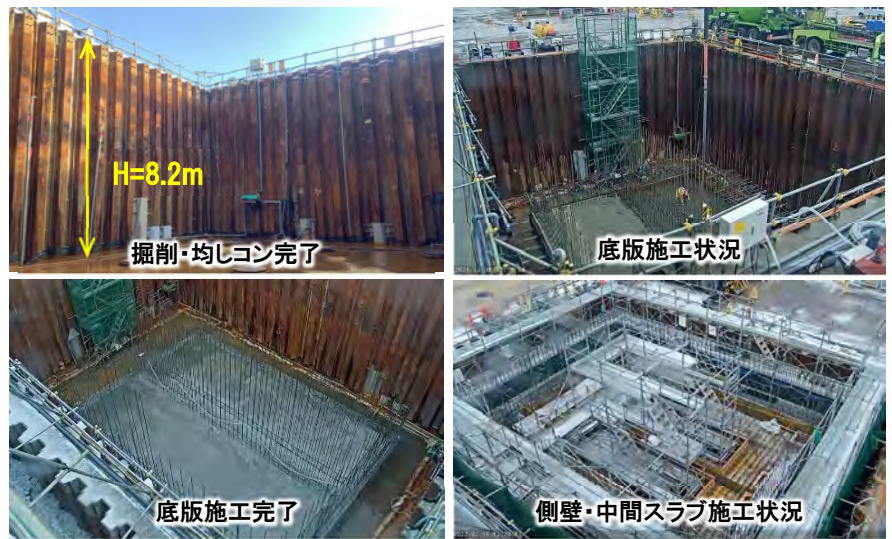
写真-7 施工実績③ 施工状況
