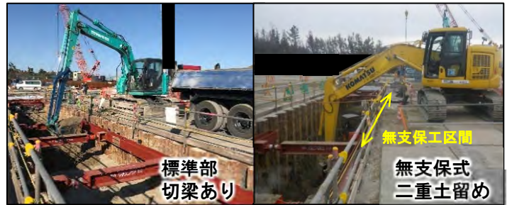
写真-2 施工実績① 掘削施工状況
