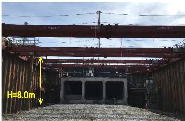
写真-6 実績② 掘削・解体完了状況
