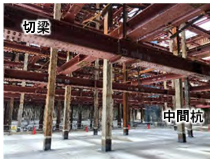
写真-1 切梁土留め例
