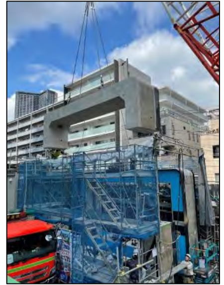
写真-3 函体組立
